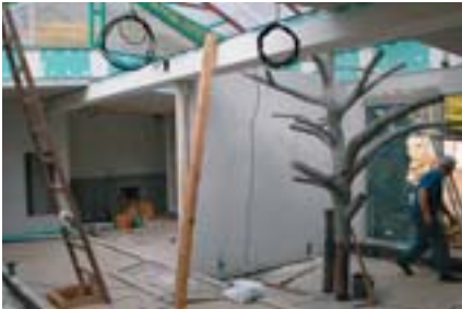
Vnitřní úpravy v novém pavilonu The interior works
