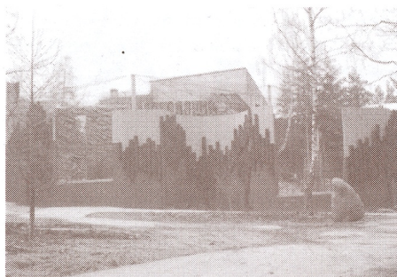
Pohled na dokončenou část rekonstrukce výběhů pavilonu šelem
