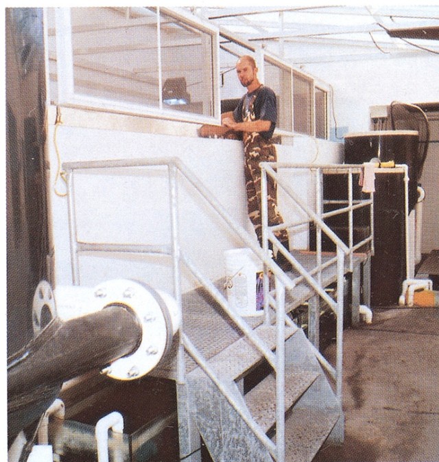
Celkový pohled na zázemí obřího akvária The complete view of the background of the big aquarium
