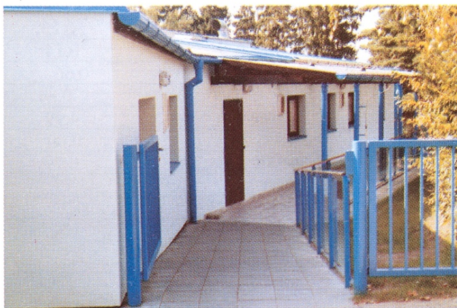
Přístavba akvárií na pavilonu šelem Enlargement of the aquarium exposition
