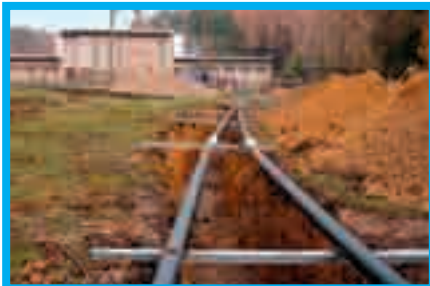
Rozvody tepla do dalších pavilonů The energy distribution to other buildings
