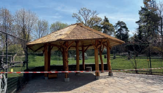
Stavba altánu u gepardů /Construction of a gazebo by the cheetahs/
