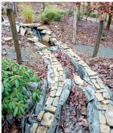
V rovných partiích byly použity drobnější kameny /Smaller stones were used in the flat sections/
