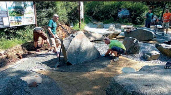
Pomoc dobrovolníků při rekonstrukci geostezky /Volunteer assistance during the geo-path reconstruction/
