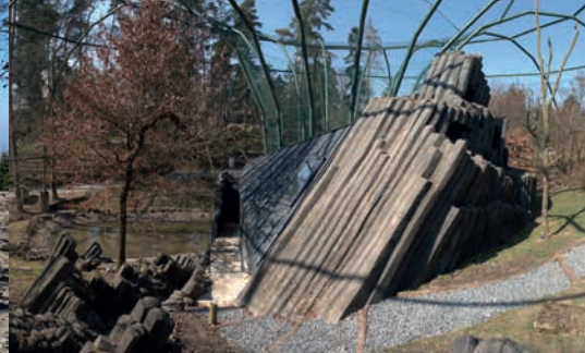
Byla dokončena rekonstrukce voliery Bábovka /The reconstruction of the Bábovka aviary has been completed/
