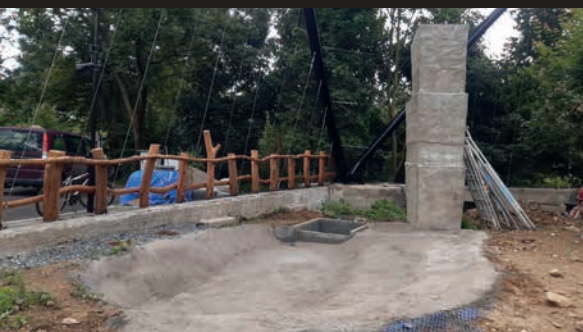
Budování jezírka ve voliře Colca /Building a pond in the Colca aviary/
