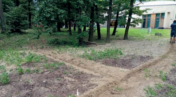
Realizace závlahového systému firmou Rainfox /Implementation of an irrigation system by Rainfox company/
