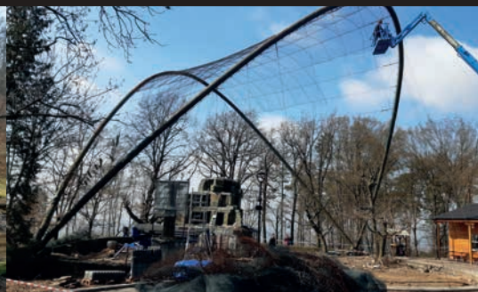
Zahájení celkové rekonstrukce obří voliery /The reconstruction of the giant aviary has started/
