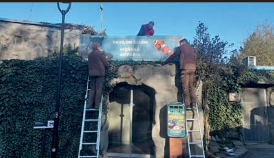
Výměna panelů na pavilonech /Panel replacement on the pavilions/
