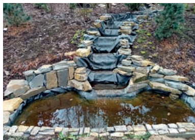
Obložení vodopádu jako příprava pro betonování /Waterfall lining as preparation for concreting/
